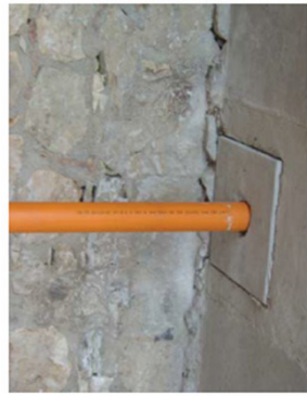
Figura 35, 36 e 37. In assenza di locali interrati o in mancanza di intercapedine sotto l'edificio è possibile posare un pozzetto interrato (o più pozzetti) realizzato con elementi prefabbricati o in muratura a nido d'ape o in plastica al quale è collegato il sistema aspirante. In pratica questo metodo consiste nello scavare una o più buche nel terreno sottostante o circostante la casa dalle quali estrarre l'aria carica di radon
