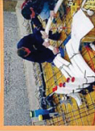
Soluzione sottomano: il tubo deve essere installato in PVC con un diametro di almeno 200 millimetri
