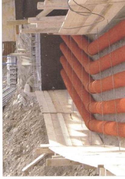
Recuperatore geotermico in un'applicazione condominiale
