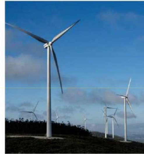
Turbine eoliche di 3 MW
